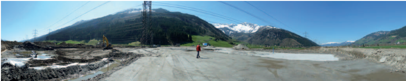
Baufeld für das Umspannwerk Schwarzenbach
