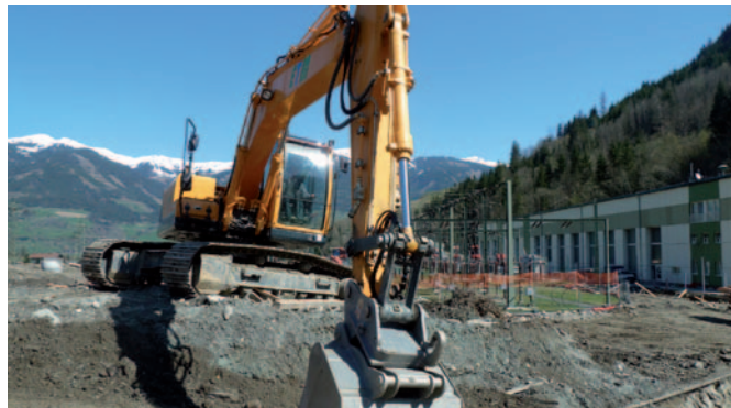
Baggerarbeiten am ÖBB-Werksgelände
